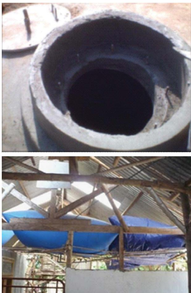
Gambar 2 Pembuatan Digester dan Tangki Biogas
